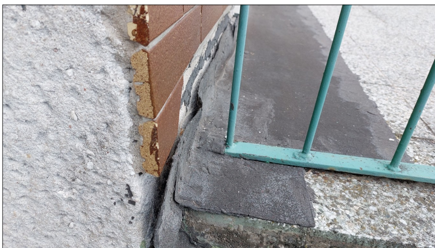
Obr.8: Netěsná dilatační spára mezi terasou a objektem
